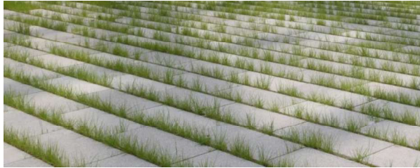
Entrée charretière en pavé béton enherbé
