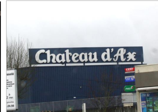
Enseigne en toiture
