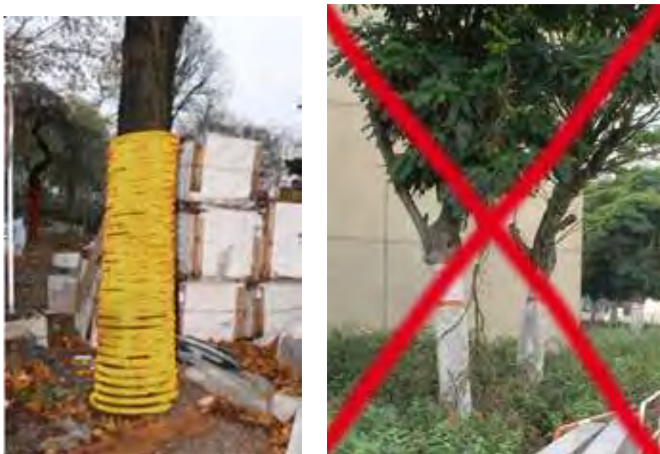
Illustration 4 : Protection des troncs avec du drain annelé perforé (pour les petites circonférences jusqu'à 45cm)
