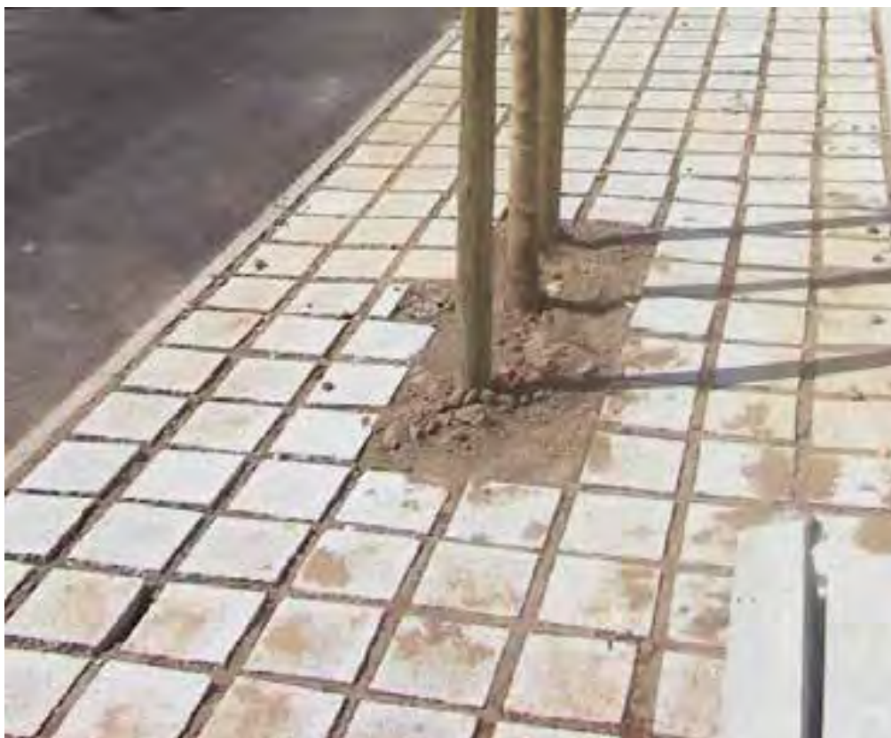
Illustration 20 : Revêtement provisoire
