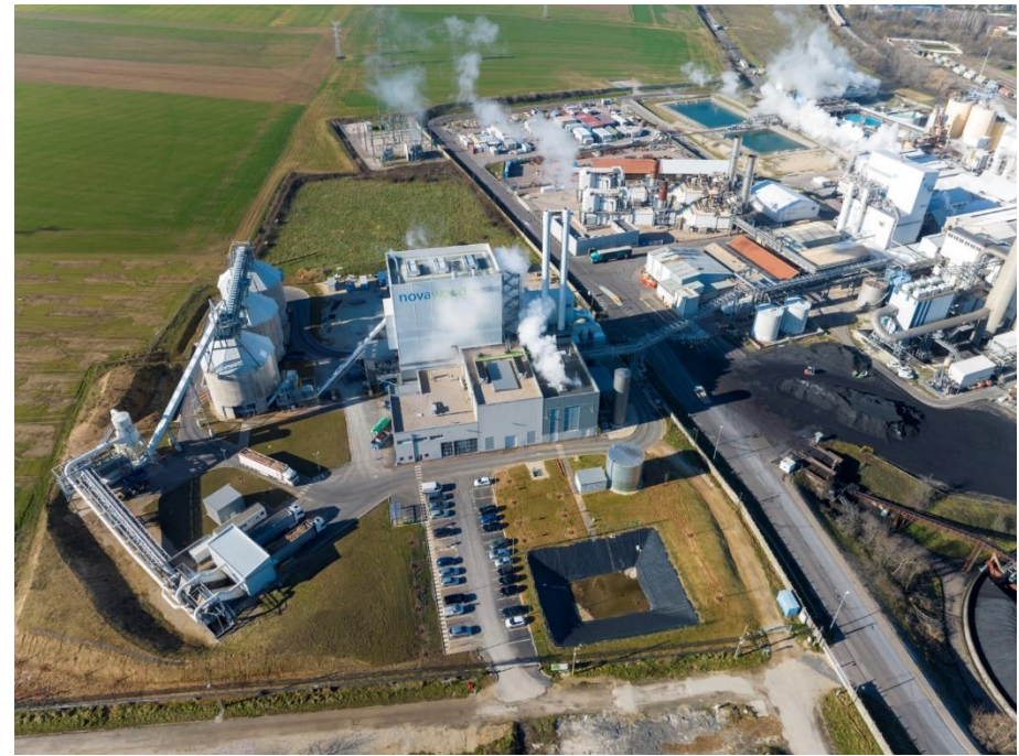
La centrale NOVAWOOD
