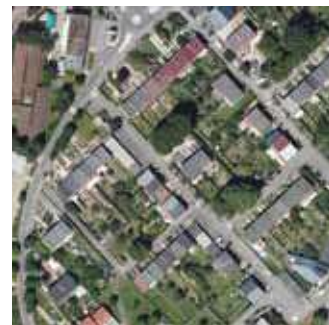
Les petites maisons identiques jumelées ou en bande du quartier Brichambeau articulent un maillage fin entre les espaces publics et les espaces privés.
