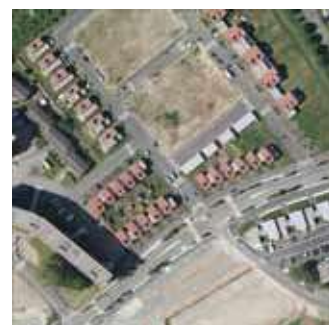
Avec l'opération Cœur de Ville à Tomblaine, la rénovation urbaine se concrétise avec la construction de nouvelles typologies de bâti.
